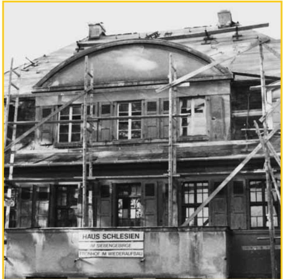
... und im November 1978 nach dem Beginn der Dachdeckerarbeiten
